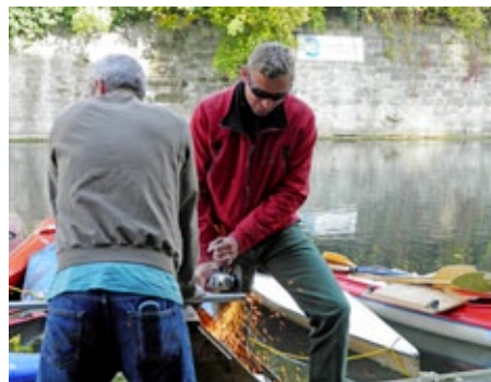
Die WVZ-Mitglieder Erik Benz (rechts) und Heinz von Känel im Einsatz beim Ablängen eines Stahlrohrs. (Foto: Olivier Bertrand)
