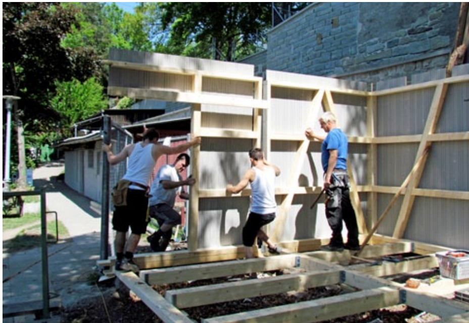
Zum Wiederaufbau des abgebrannten Bootshauses 7/8 montieren Zimmerleute im Auftrag der Stadt Zürich vorgefertigte Holzwände. (Foto: Jürg Christoffel)
