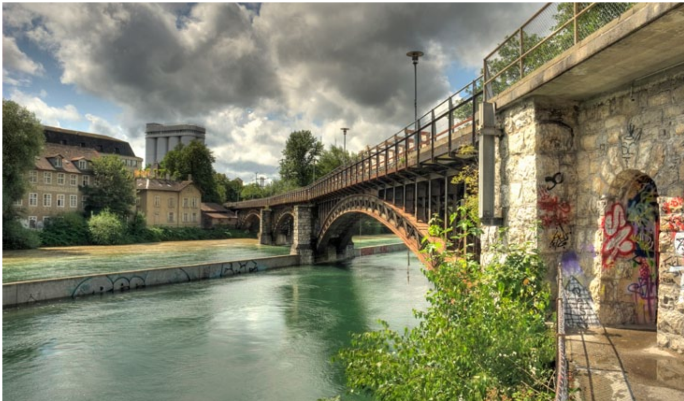
Die Brücken des Lettenviadukts werden saniert. (Foto: ManImMac, Flickr)
