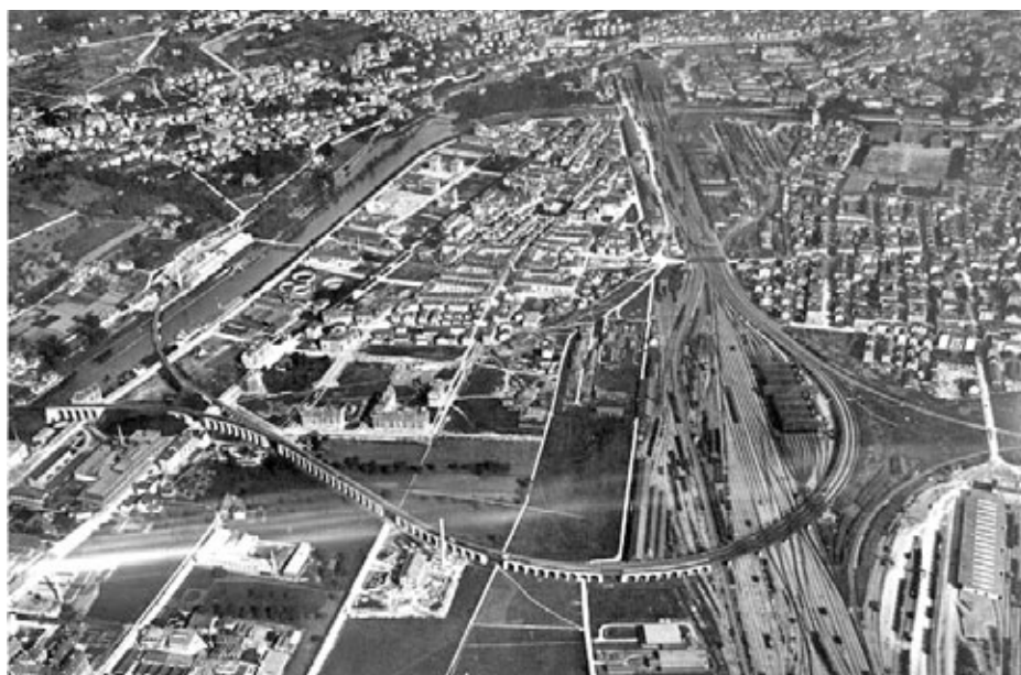
Aufnahme aus dem Ballon von Kapitän Eduard Spelterini von 1898: Der Aussersihler Viadukt führt in grossem Bogen über das Gleisvorfeld des Hauptbahnhofs Zürich und teilt sich auf in den Wipkinger Viadukt (nach links) und den Lettenviadukt (nach rechts).
