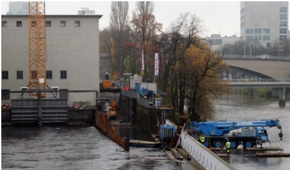
Das ewz schafft beim Kraftwerk Letten für Fische die Möglichkeit, dieses Hindernis zu überwinden. Das Foto zeigt die Bauarbeiten im November 2009. (Foto: aaj)
