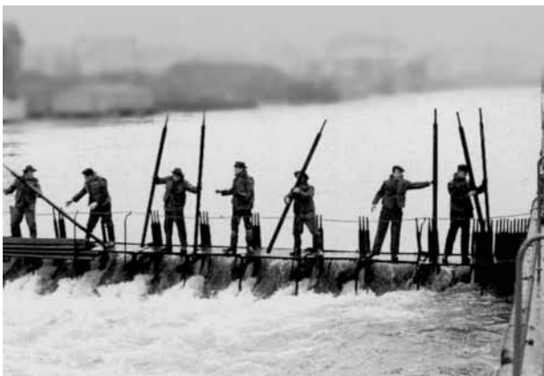
Bis 1949 wurde der Pegel des Zürichsees durch ein Nadelwehr geregelt. Je nach abzulassender Wassermenge wurde der Durchfluss mit mehr oder weniger sogenannten Nadeln (schmale, lange Holzbretter) eingeengt oder verbreitert – eine strenge und bei Hochwasser gefährliche Arbeit. Bekannt ist das Nadelwehr, das heute noch in Luzern den Pegel des Vierwaldstättersees regelt. (Foto: ewz)
