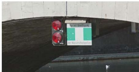
An der Münsterbrücke sperrt eine Zweikammerampel bei Hochwasser die Limmat für jeglichen Schiffsverkehr.
